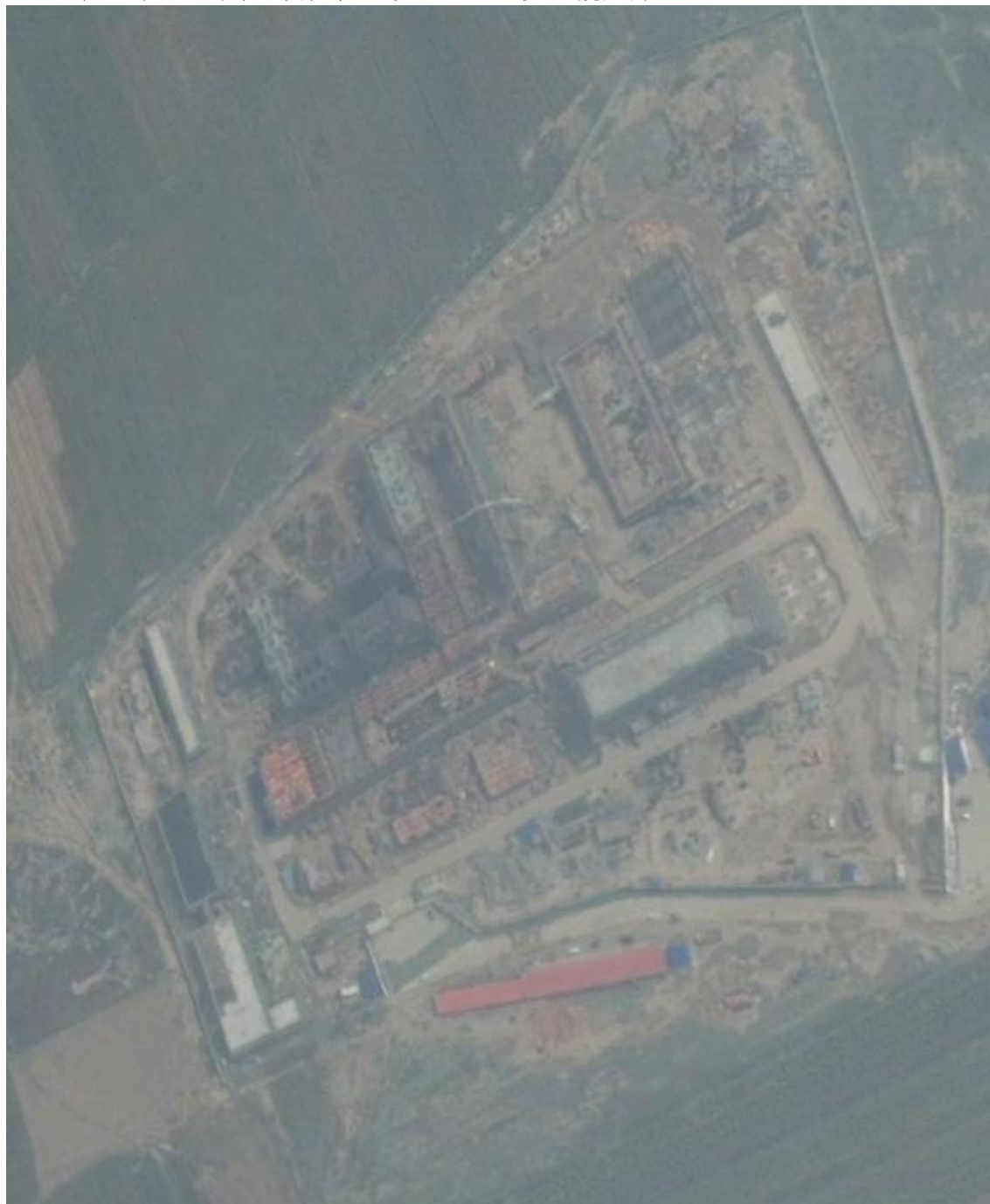
2016 年 9 月监测单位进场时遥感监测无人机拍摄照片：
