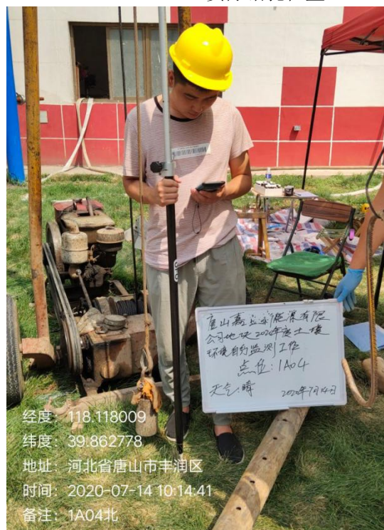
实际钻孔位置（原点位地面下存在坍塌，向 原点位东偏移 1.1m）
