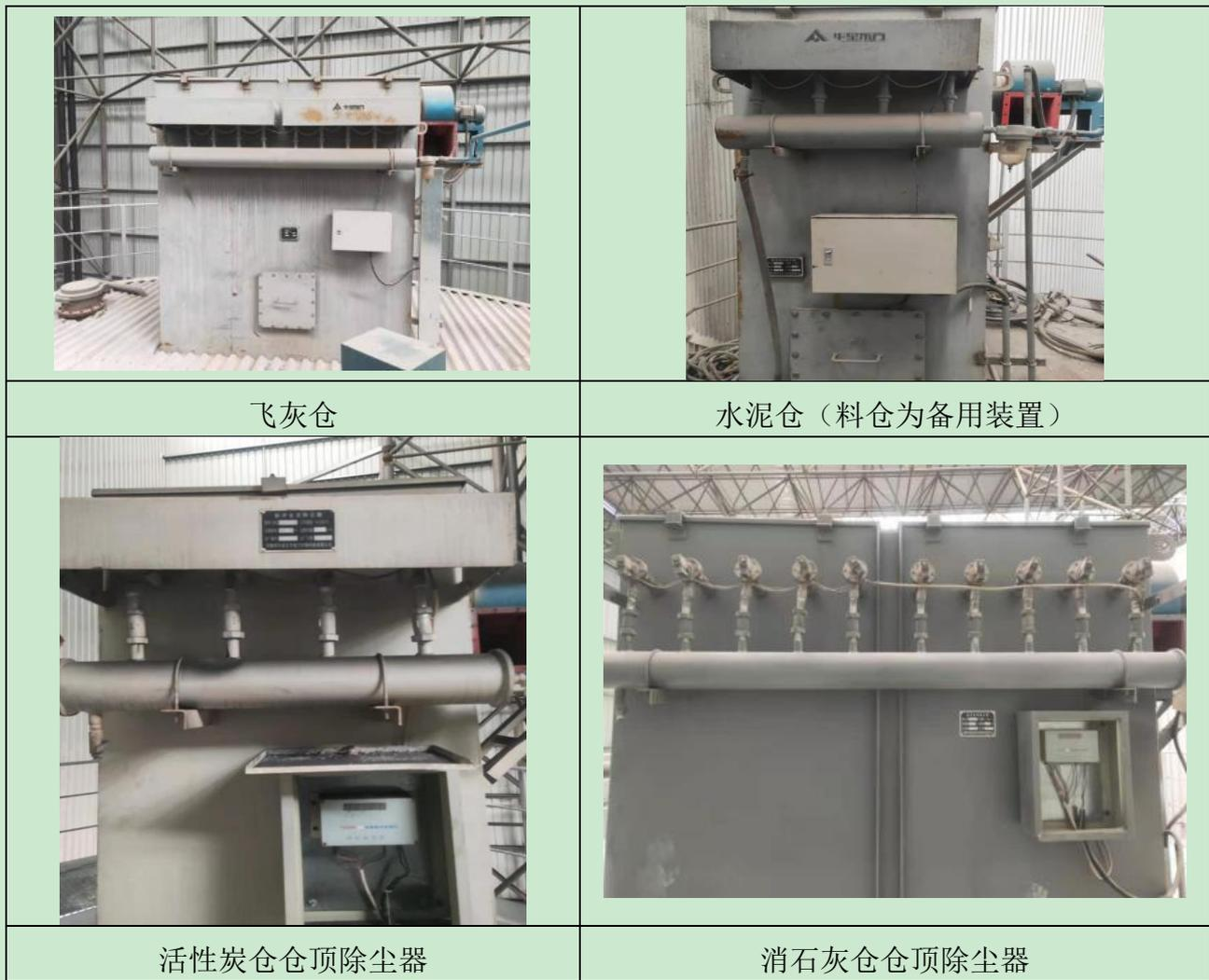
图 4.1-4 料仓废气污染控制措施
