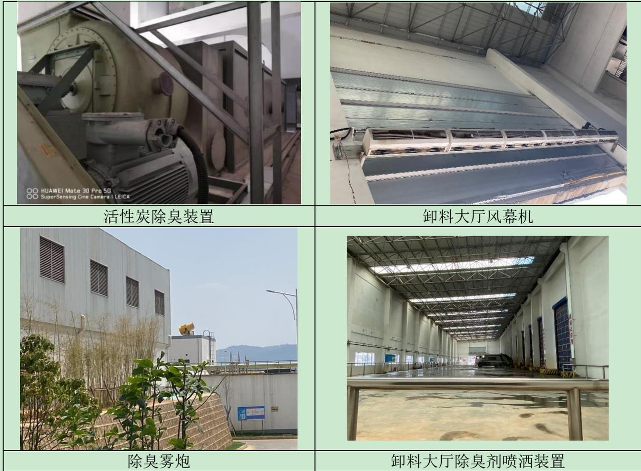
图 4.1-7 废气污染控制措施
