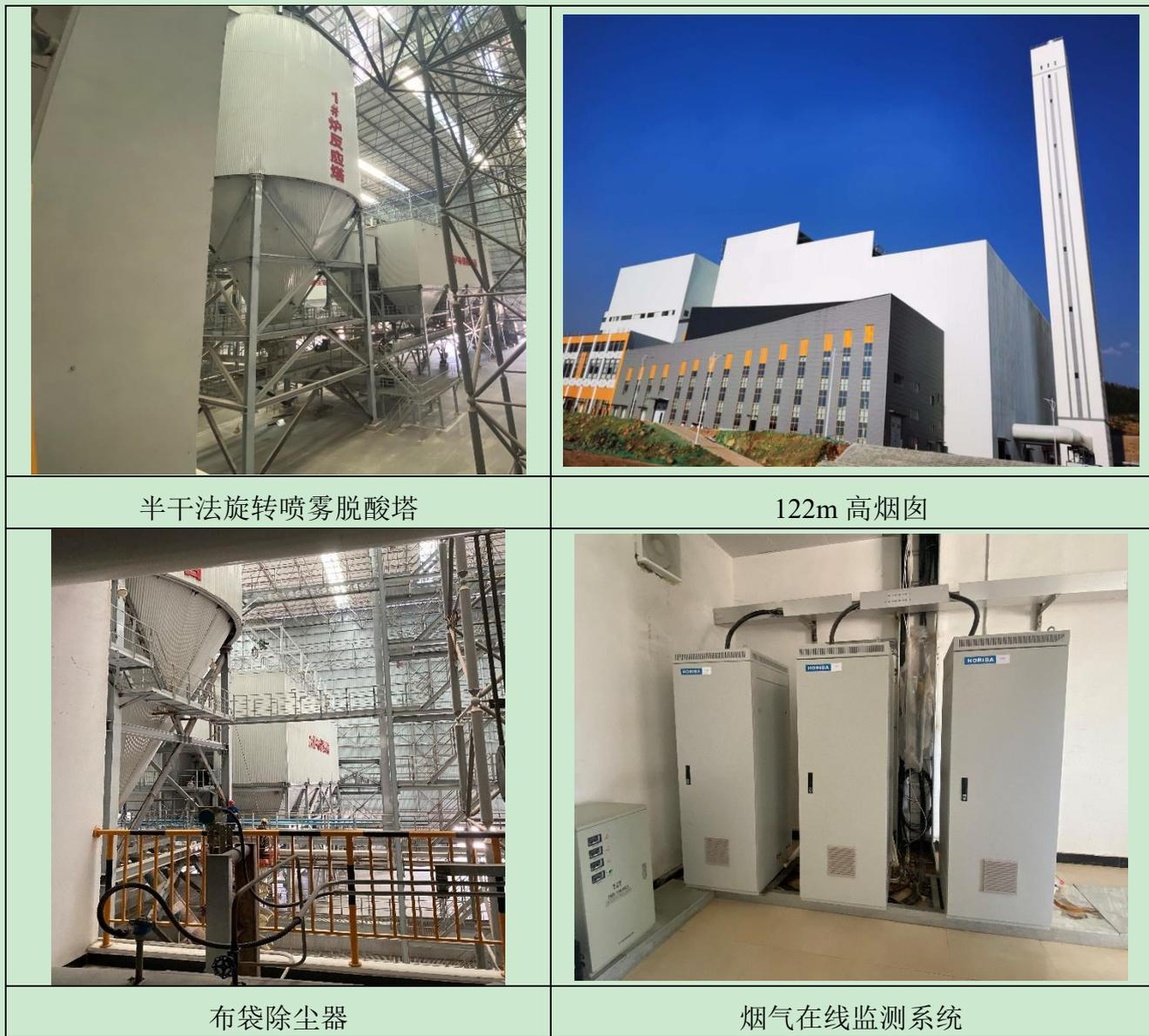
图 4.1-4 废气污染控制措施
