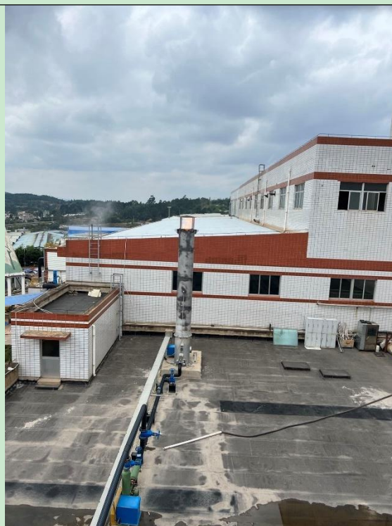
渗滤液处理站安全火炬
