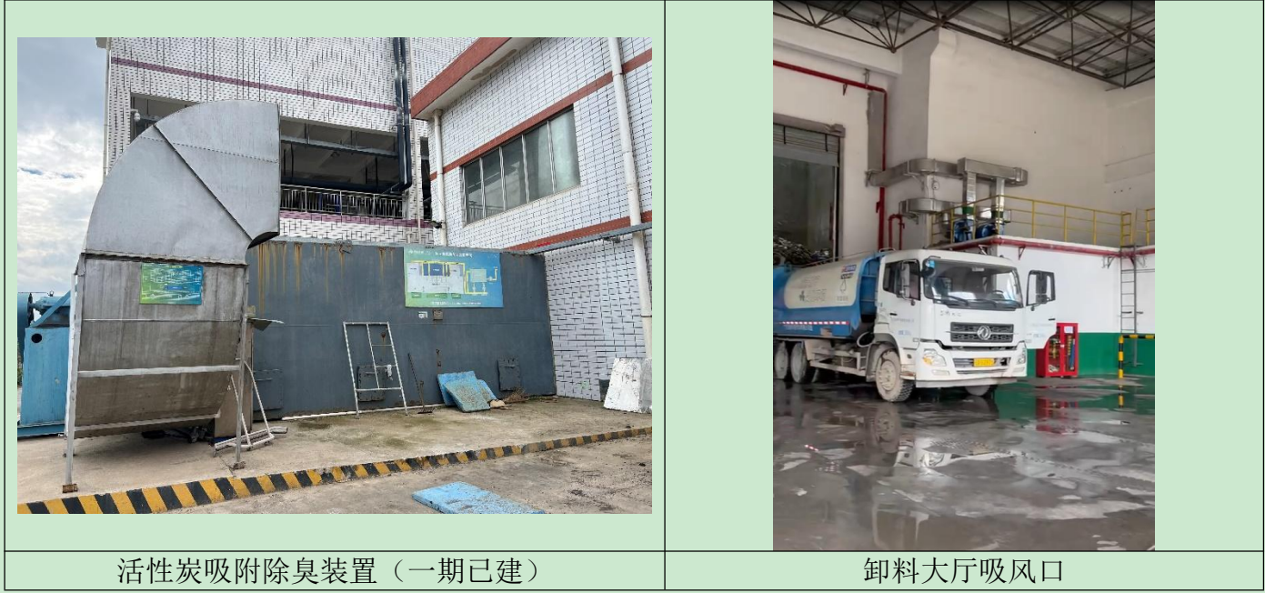
图 4.1-7 废气污染控制措施
