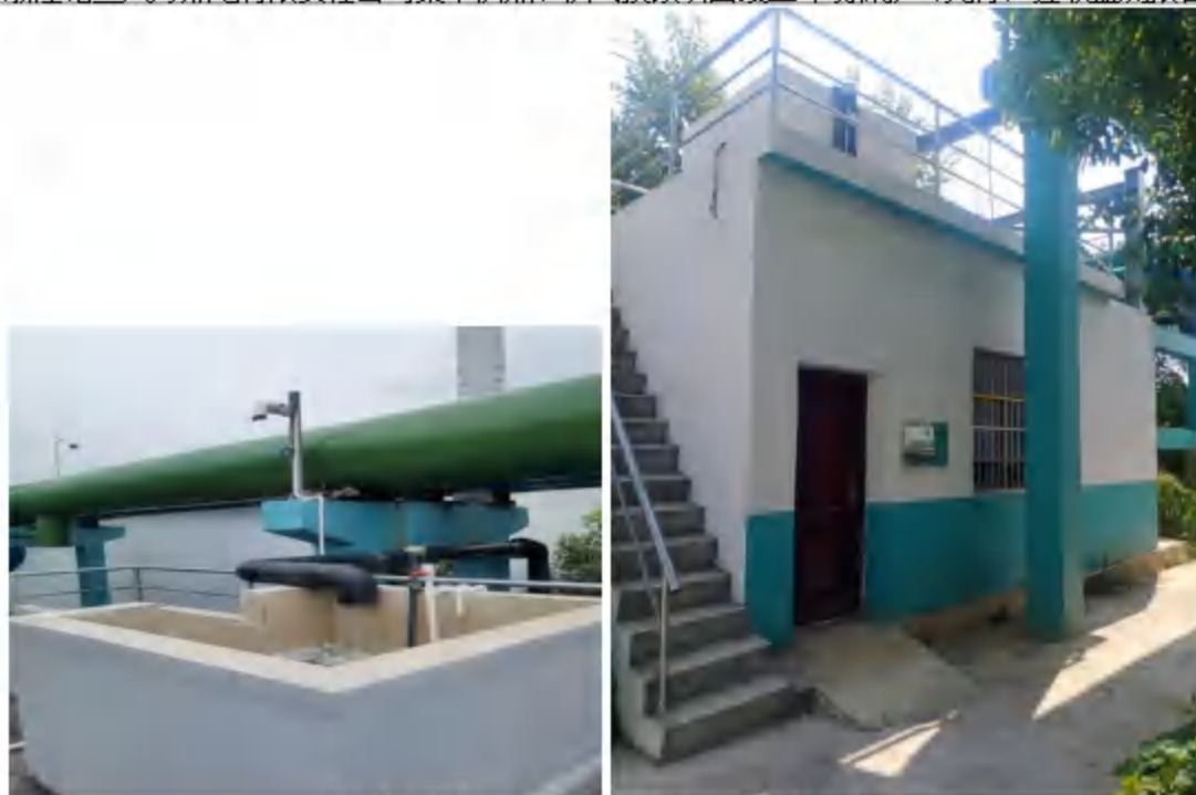
污水总排口及在线监测、监控设施
