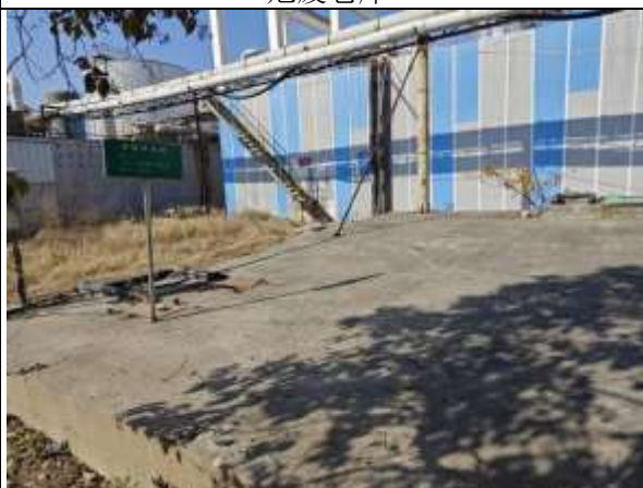
初期雨水收集池
