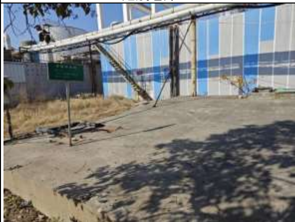
初期雨水收集池
